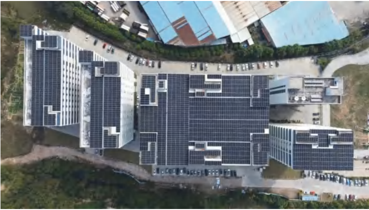
屋顶分布式光伏发电项目航拍
